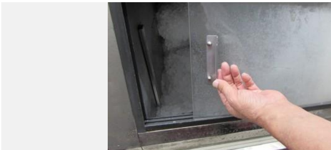
ボルトの緩みがないかチェック
